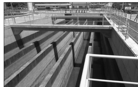
Figura 26 – Tanque de Desinfecção.
