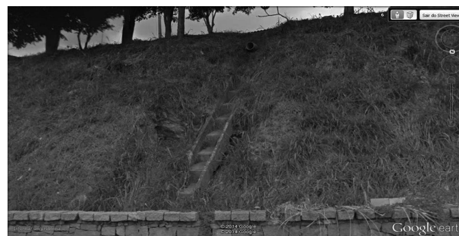
Figura 46 – Escada de Dissipação de Energia.
