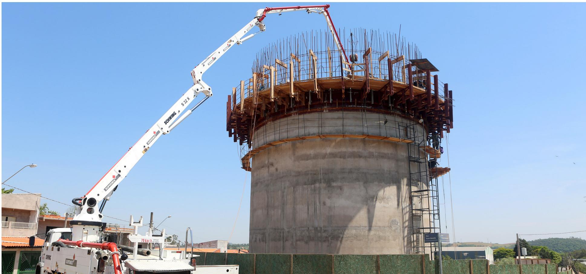
*Fase de engenharia civil da obra está avançada, com paredes já levantadas e faltando apenas a construção da última laje*
