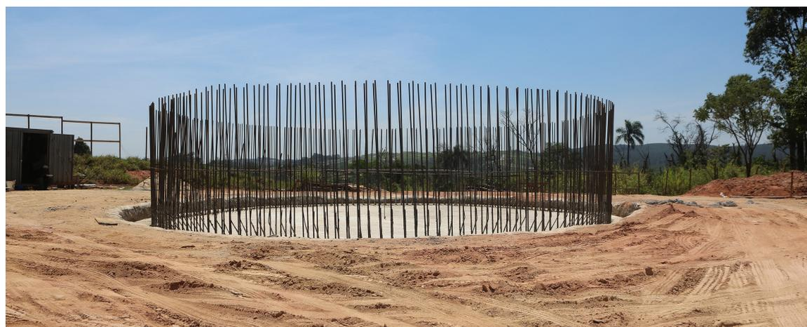
Jardim Juliana, uma vez que os dois reservatórios possuem estrutura semelhante. Esta forma serve para moldar o concreto da parede na ondulação e tamanho corretos, conforme o projeto do reservatório. A obra fica
