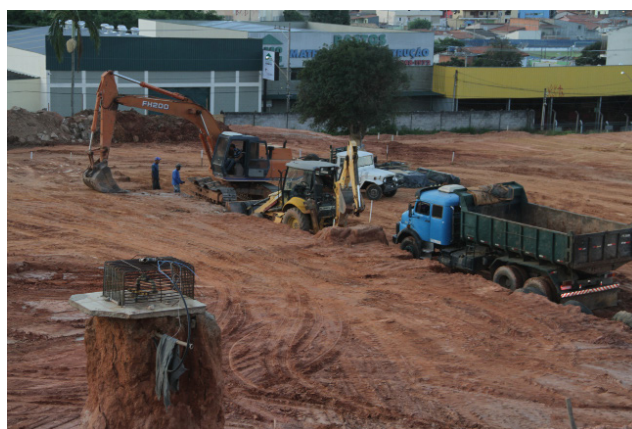
Obras Creche Santo Antônio
