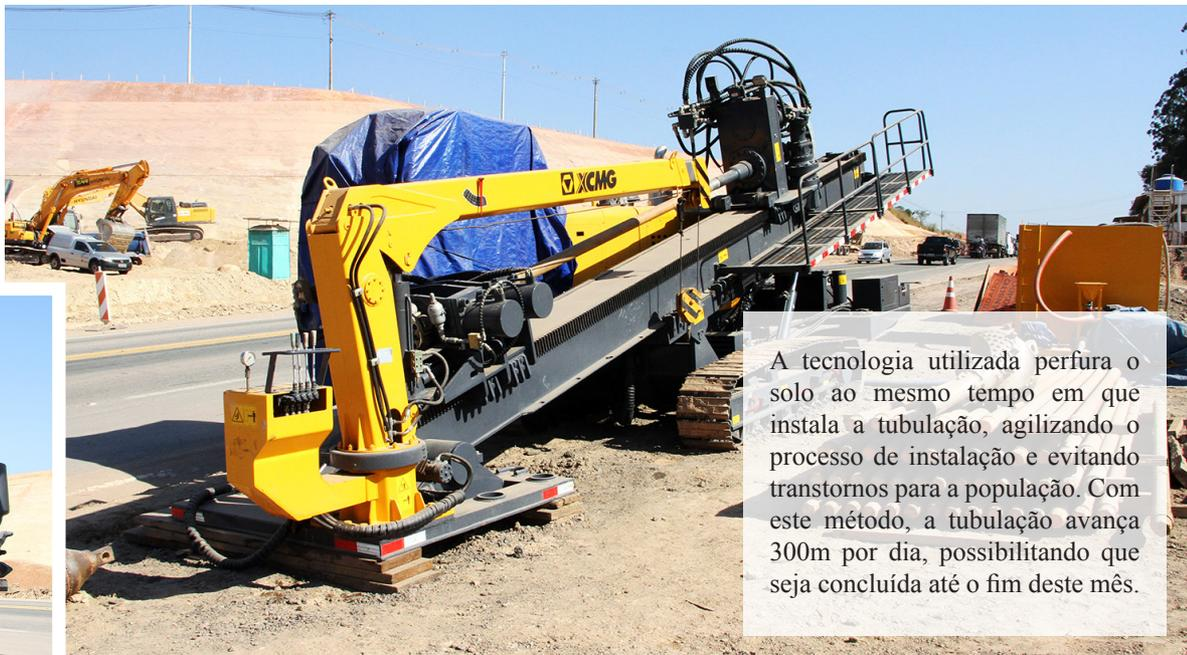
A tecnologia utilizada perfura o solo ao mesmo tempo em que instala a tubulação, agilizando o processo de instalação e evitando transtornos para a população. Com este método, a tubulação avança 300m por dia, possibilitando que seja concluída até o fim deste mês.
