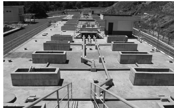
Figura 22 – Reatores Anaeróbios de Fluxo Ascendente.
