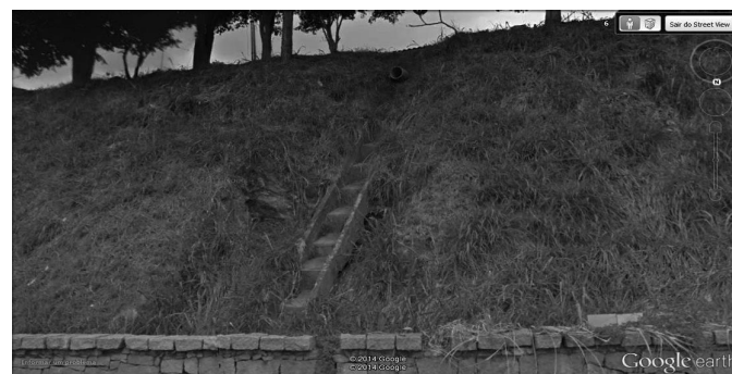
Fonte: Google Earth, 2014. Figura 46 – Escada de Dissipação de Energia.
