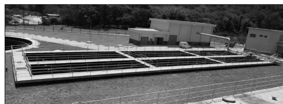
Figura 23 – Tanques de Aerção.
