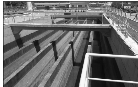
Figura 26 – Tanque de Desinfecção.
