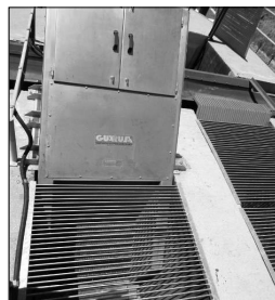
Figura 21 – Gradeamento (Peneiramento) tipo Escada.
