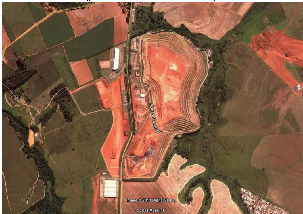
Figura 16 Vista do aterro Estre em Paulínia/SP.
