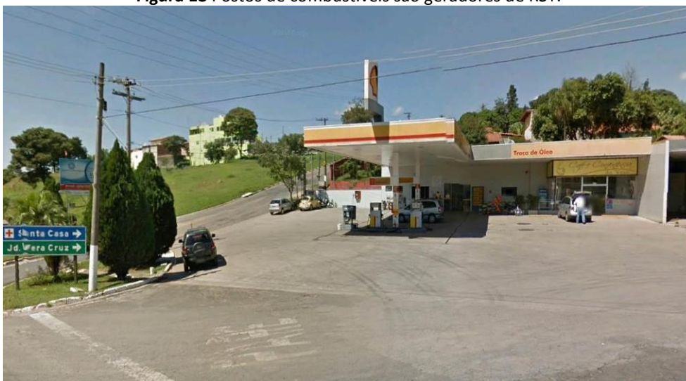
Figura 18 Postos de combustíveis são geradores de RST.
