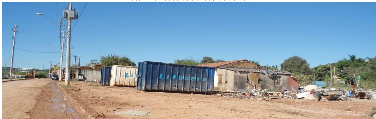
Foto 11 Unidade de transbordo de RCD.
