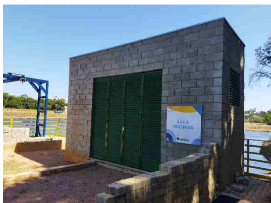
Figura 9.8. EEAB da captação do Córrego do Fetá - Casa de equipamentos e elétrica.
