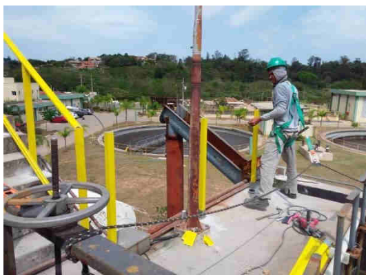
Figura 10.6. Guarda-Corpo do Reator UASB sendo trocado.
