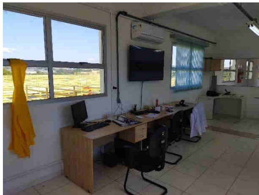
Figura 9.36. Centro de Controle de Operações (CCO) instalado na Estação de Tratamento de Água.
