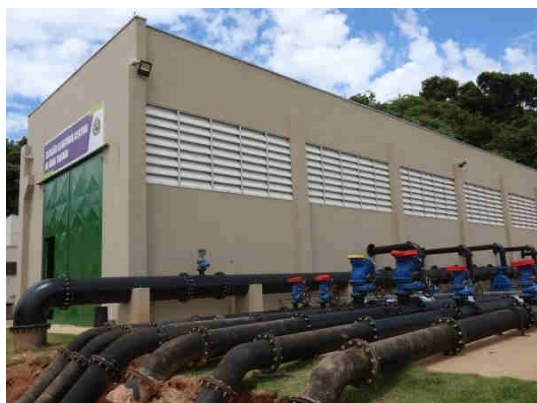
Figura 9.22. Estação Elevatória de Água Tratada Central.
