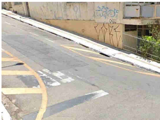
Figura 12.18. Boca de lobo de guia simples sem depressão.
