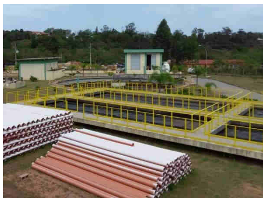
Figura 10.7. Guarda-Corpo do tanque de aeração trocado.
