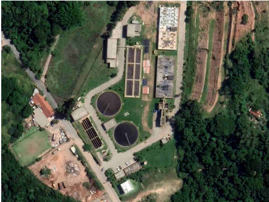
Figura 10.3. Estação de Tratamento de Esgoto do município de Louveira.
