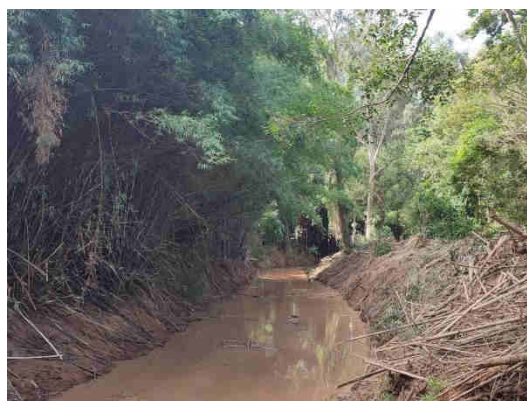
Figura 12.13. Limpeza e desassoreamento da calha do Rio Capivari no Bairro Jd. Niero.
