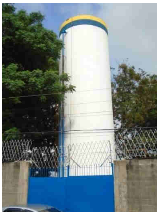
Figura 9.27. Reservatório R22 com as “não conformidades” atendidas
