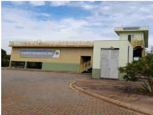
Figura 9.18. Estação de Tratamento de Água - ETA II.
