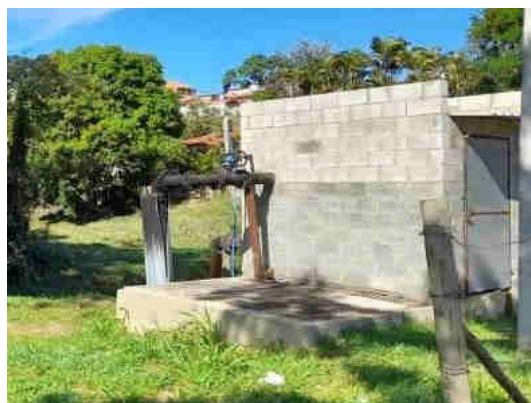
Figura 9.7. Casa de bombas da captação do Rio Capivari.
