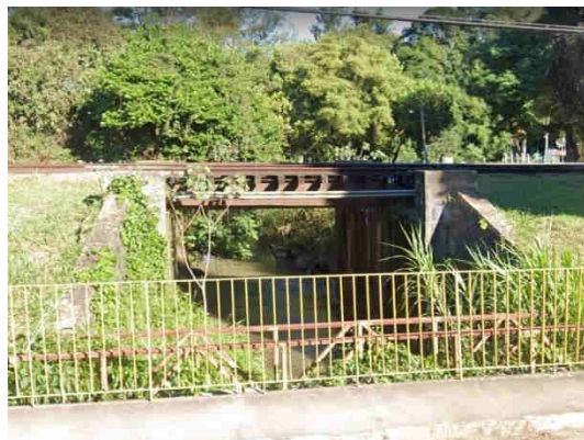
Figura 12.6. Travessia (TR 09) da Linha Férrea sobre o Rio Capivari.
