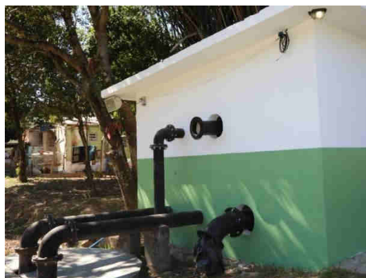
Figura 9.5. Tomada d'água da captação do barramento do Córrego Água do Buracão.
