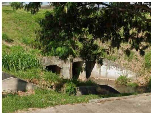
Figura 12.7. Travessia (TR 14) da Rodovia Anhanguera sobre o Córrego Santo Antônio.
