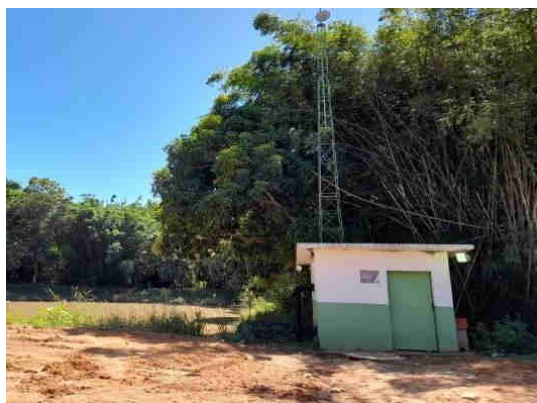
Figura 9.4. Casa de bombas da captação do barramento do Córrego Água do Buracão.
