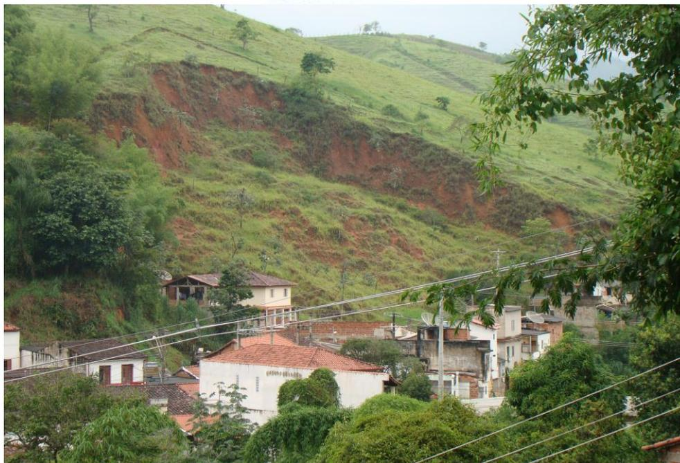
**Figura 6**– Deslizamento circular ou rotacional.
