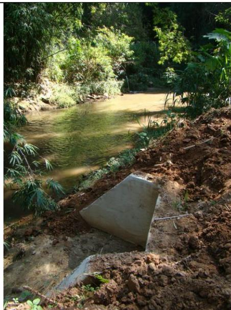
**FOTO 30.** Vista geral do rio Capivari e estrutura de dissipação de energia das águas coletadas da rua Rodrigues Alves. Notar que a elevação das águas do rio poderá bloquear o sistema, provocando refluxo das águas.
